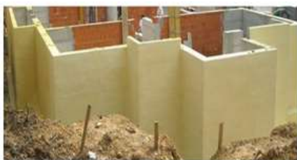
Рис.2. Гідроізоляція фундаменту – рідка гума
