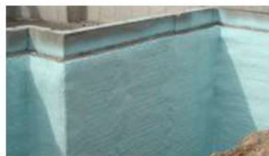
Рис.3. Гідроізоляція фундаменту полімерна мембрана
