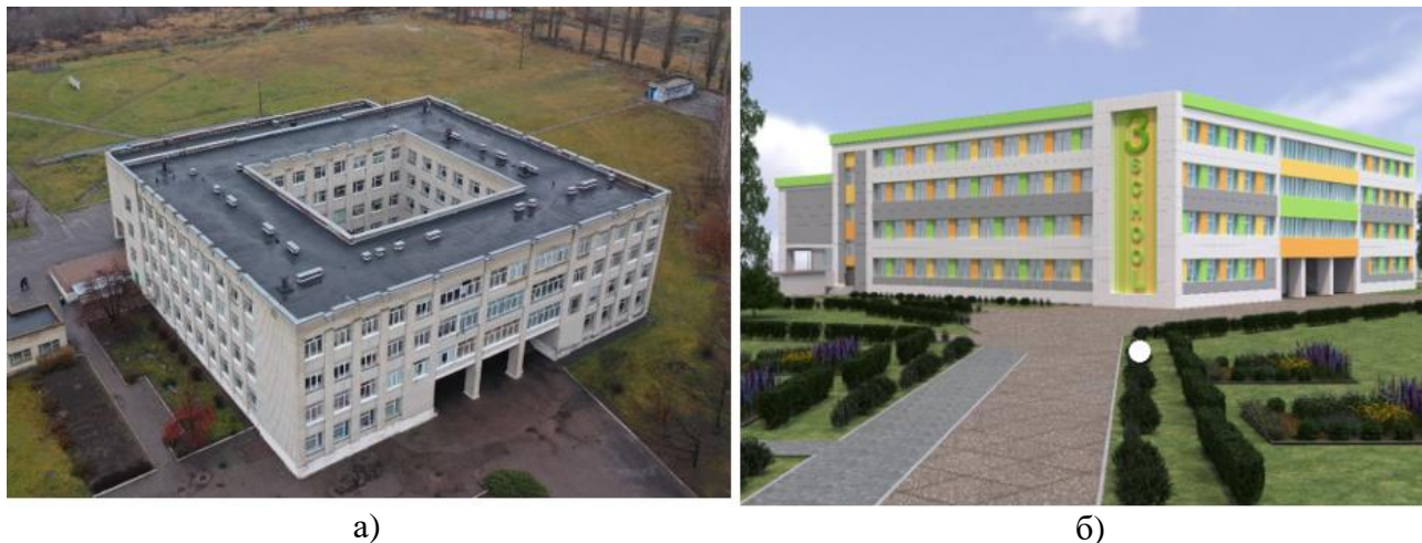
Рис1. Будівля школи: та, що існує -а; будівля після реконструкції -б
