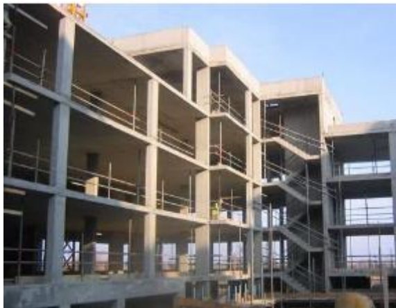
Рис.1 Будівля з монолітним каркасом
