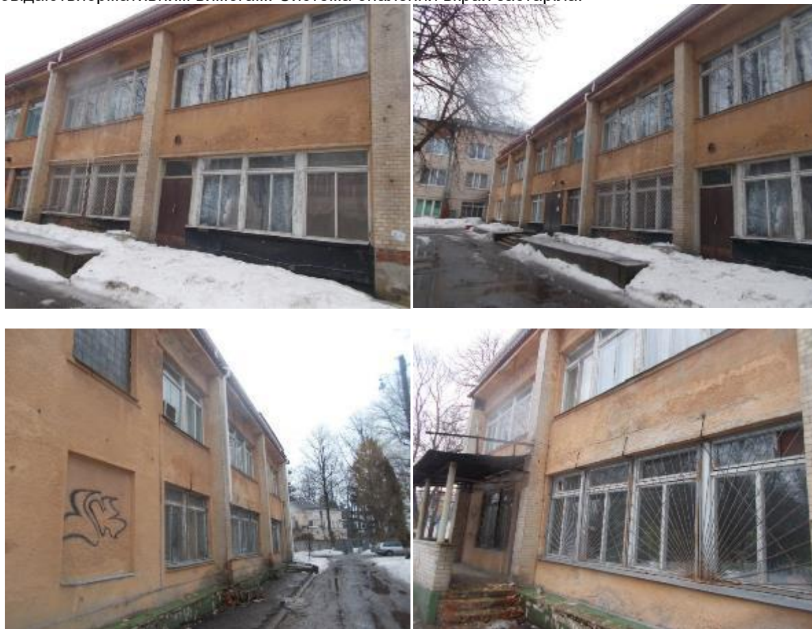
Рис. 1 Будівля до капітального ремонту
