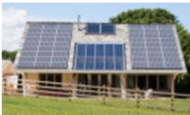
Рис.1 Загальний вигляд енергозберігаючого будинку
